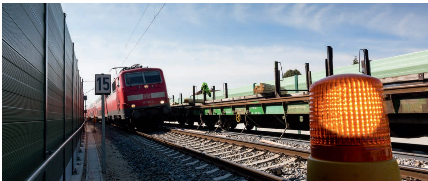
Im PFA 3.0 werden 700 Meter Schallschutzwände gebaut (Symbolbild).
