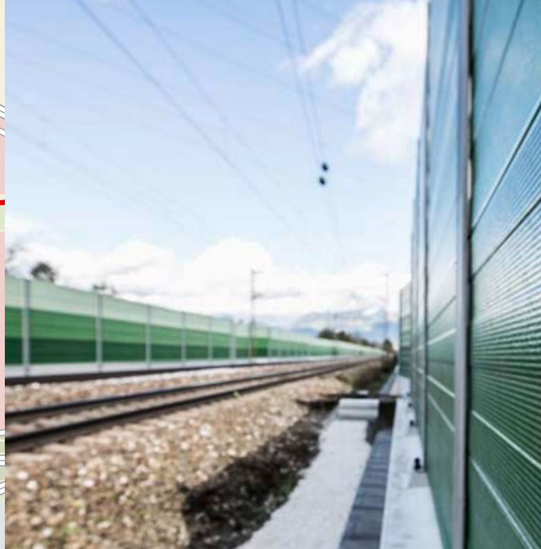
Im PFA 3.0 werden rund 700 Meter Schallschutzwände gebaut (Symbolbild).
