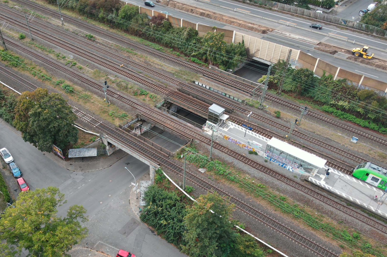
Die Eisenbahnüberführung Im Schlenk wird im Rahmen des sechsgleisigen Ausbaus erweitert.
