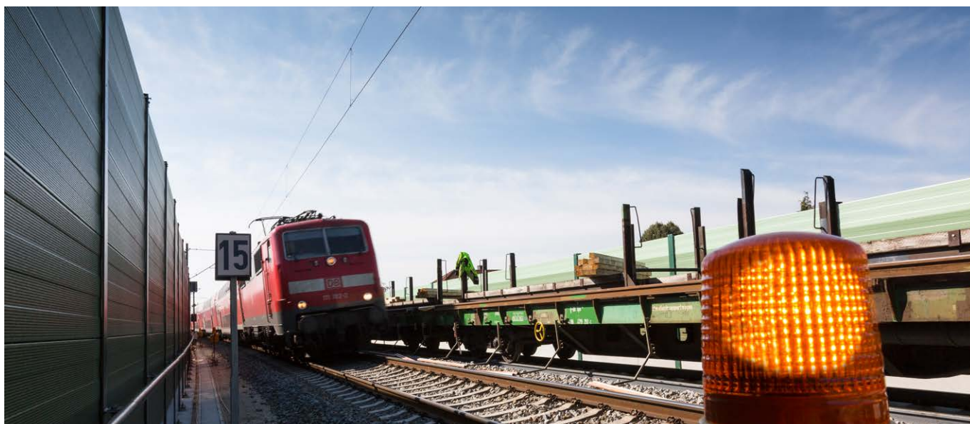
Im PFA 3.2a werden insgesamt 4,5 Kilometer Schallschutzwände gebaut (Symbolbild).
