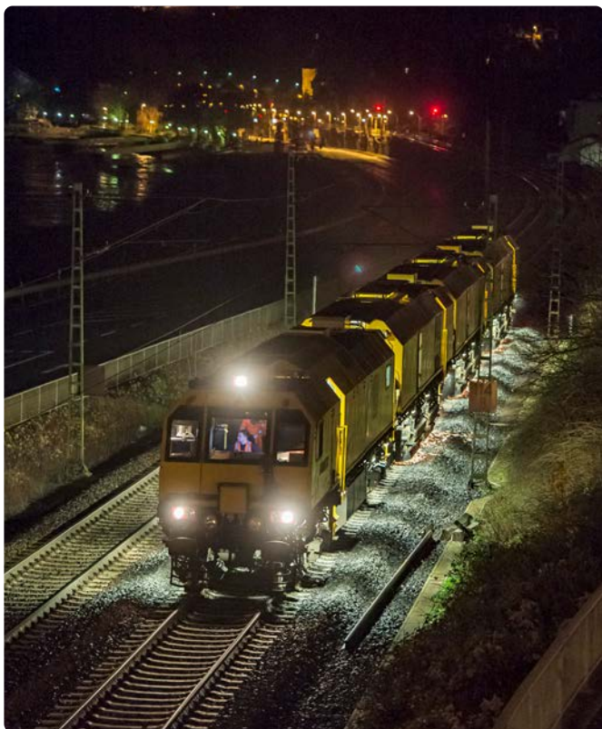
Im PFA 5a wird das Besonders überwachte Gleis (BüG) eingesetzt. Dabei überprüft ein spezieller Schleifzug regelmäßig den Zustand der Schienen und schleift diese wenn nötig ab. Damit wird eine Lärminderung von bis zu drei Dezibel erzielt.
