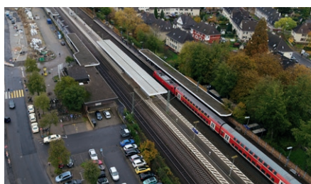
Der Bahnhof Leverkusen Mitte wird im Zuge der Ausbaurbeiten umgebaut.
